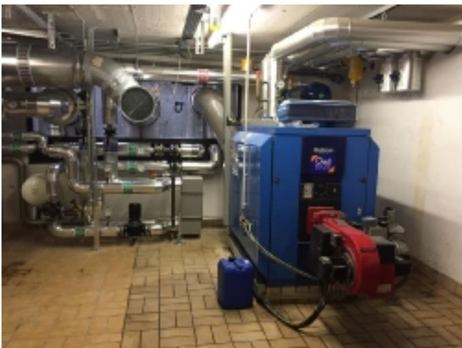
**Abb. 36:** Kessel Klärgas/Heizöl mit 295 kW, Bj. 1997
